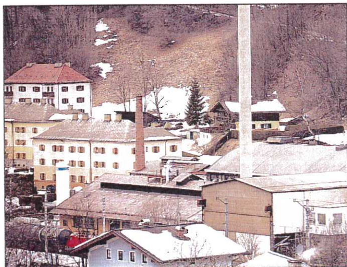
Das Aluminiumwerk in der Gemeinde Lend im Süden von Salzburg
